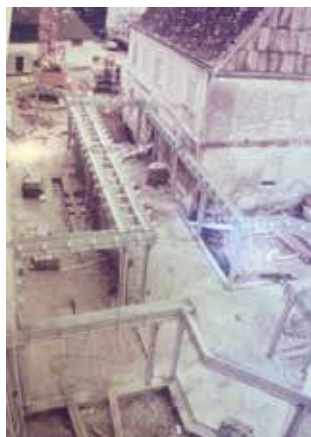
Rohbau der Seitenkapelle mit dem unrenovierten Pfarrhaus im Hintergrund.
